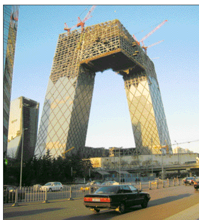
Sede della televisione nazionale (CCTV), di OMA
